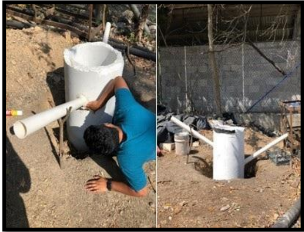
Colocación de conductos de carga y descarga
