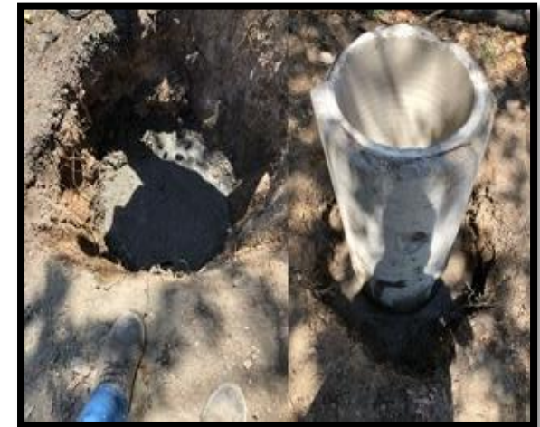
Embaldosado y colocación del tubo de concreto
