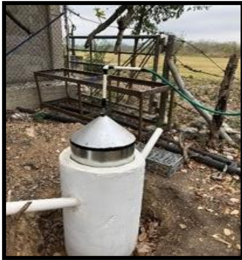
Colocación de campana flotante
